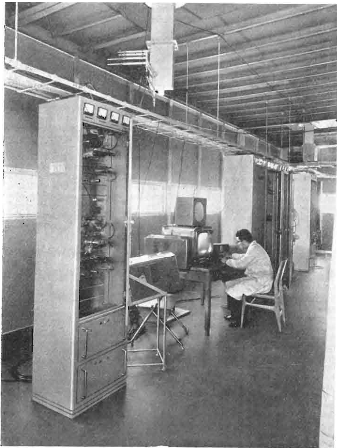
Centro R.A.I. TV di Milano; apparati radio nella cabina della torre ponti radio operanti nella direzione Roma-Palermo.
